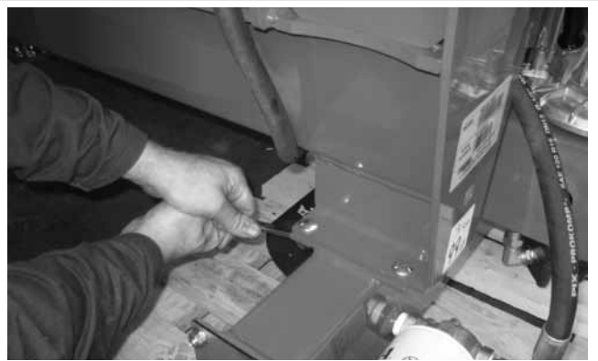
Fixation du châssis au réservoir de l'essieu
